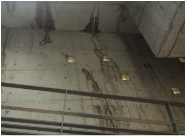
Ilustración 4: Infiltraciones en el edificio
