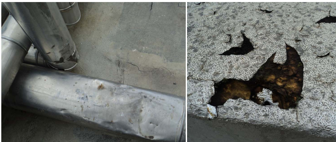
Ilustración 12: Detalles de las conducciones de climatización
