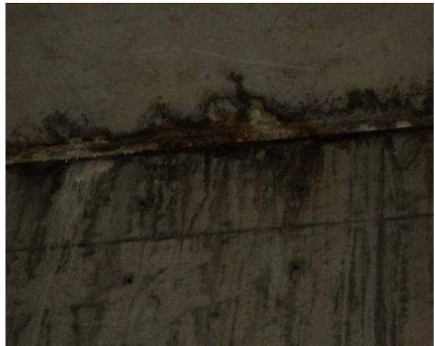
Ilustración 4: Infiltraciones en el edificio
